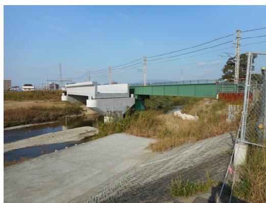
橋梁工事状況
