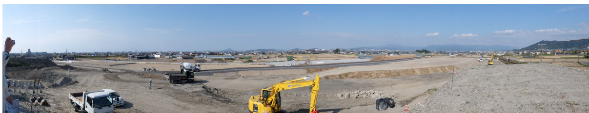
工事状況写真
