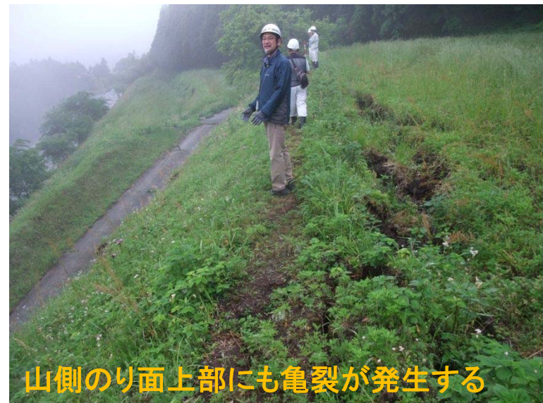
谷側が転倒崩壊し、山側小崖地形をなす
