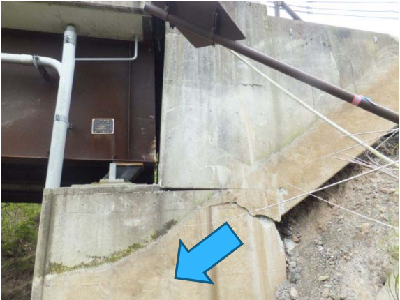
背面地山の変位と橋台の沈下
