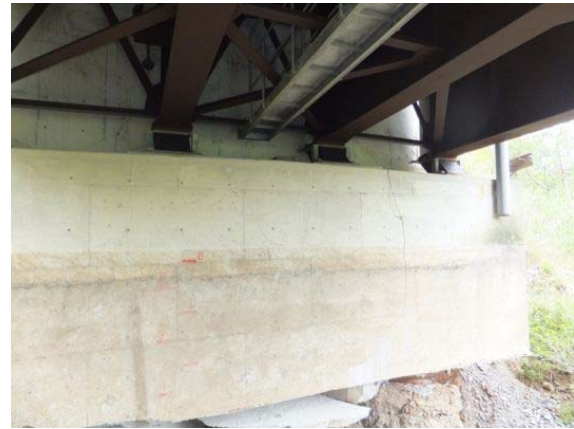
背面地山の変位と橋台の沈下
