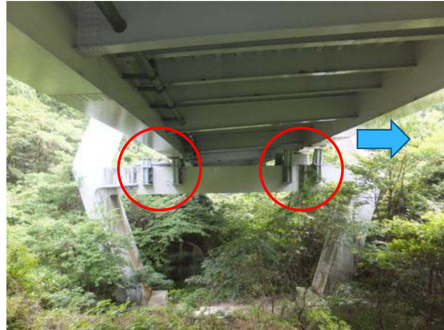
橋脚部（支承の損傷により主桁は谷側へ移動）
