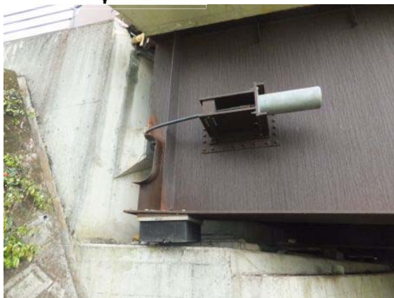
支承の損傷と落橋防止装置(落橋を寸前で拘束)
