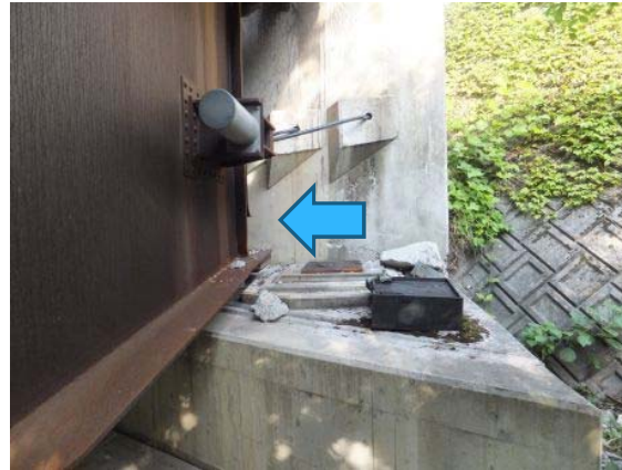
支承の損傷と落橋防止装置(落橋を寸前で拘束)
