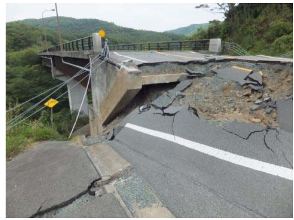
背面地山の変位と橋台の沈下
