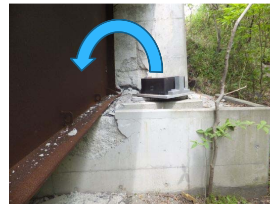
上部工横移動+支承脱落
