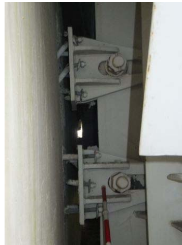
A 1 橋台側（上部工の変位を拘束出来ており、比較的損傷は小さい）
