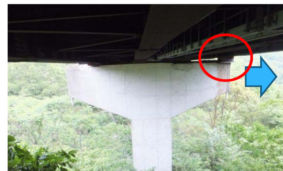
上部工横移動(落橋寸前)
