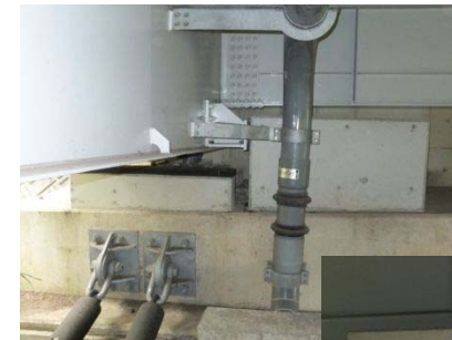
橋脚部（支承の損傷により主桁は谷側へ移動）
