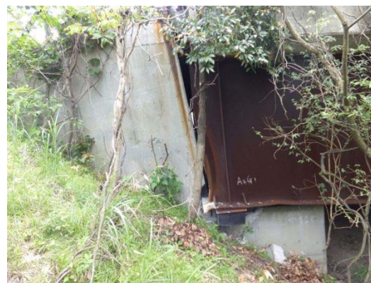
上部工横移動+支承脱落
