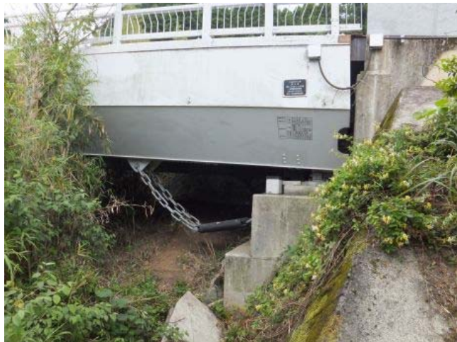
A 1 橋台側（上部工の変位を拘束出来ており、比較的損傷は小さい）
