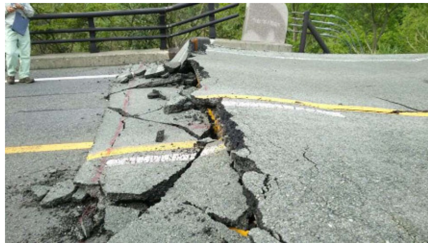
桁が橋台に衝突 橋台部が盛り上がり、段差が生じる
