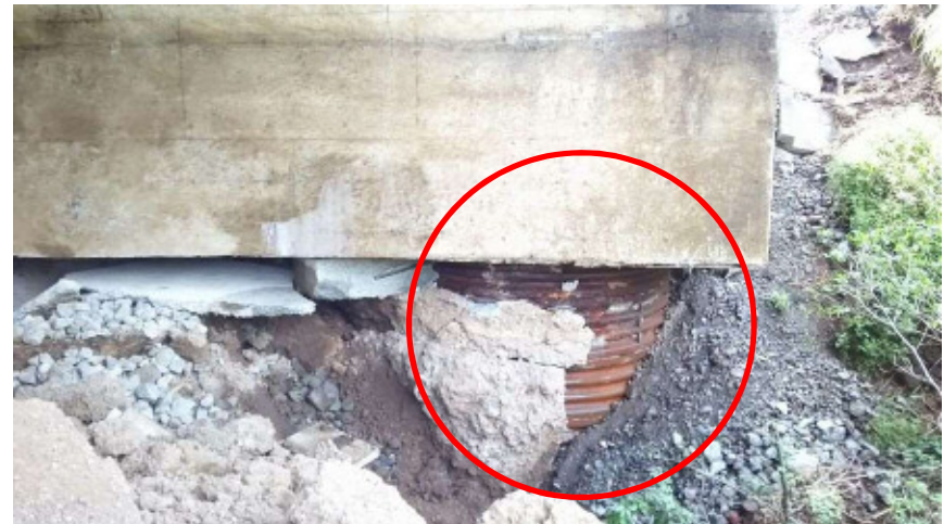
橋台周辺の盛土が崩壊 深礎杭の露出 橋台に縦ひび割れ
