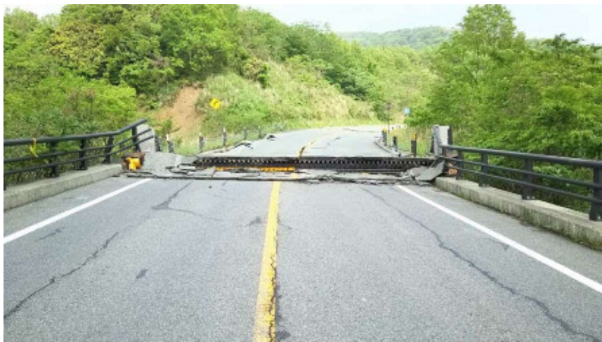
桁が橋台に衝突 橋台部が盛り上がり、段差が生じる
