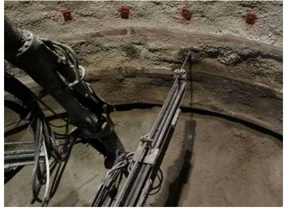
ロックボルト穿孔状況
