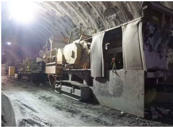
掘削ズリ破碎機とベルトコンベア
