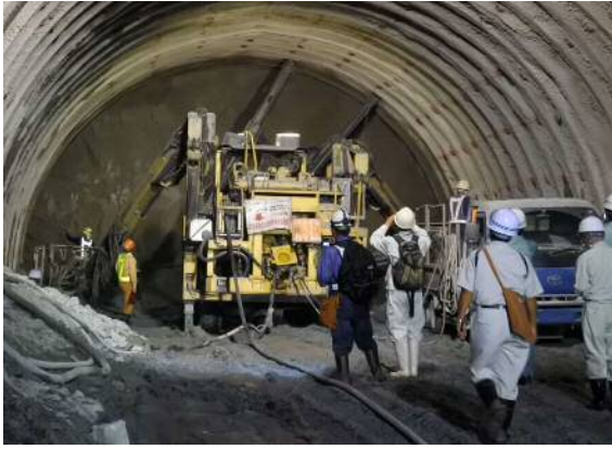
切羽付近見学状況
